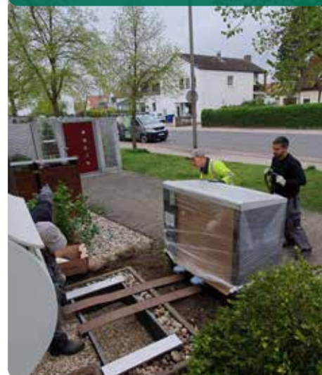
Und außen bezog die neue Wärmepumpe ihren Platz im Vorgarten.
