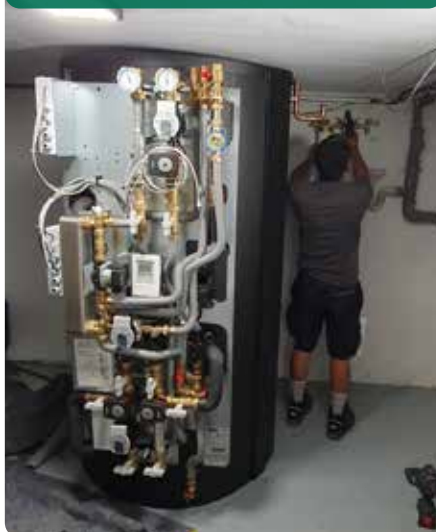
... für die Elemente der neuen Anlage, z.B. dem Pufferspeicher.
